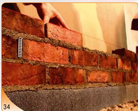
Při zdění necháme lehce přetékat zdicí maltu ze spar ven, abychom později měli čím dotvářet konečnou podobu spáry.
