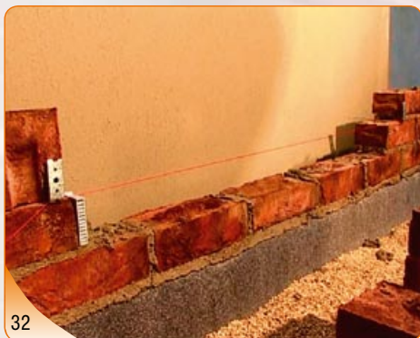
Mezi dva založené rohy napneme do požadované výšky pevnou tenkou zednickou šňůrku a ta nám vymezí požadovanou úroveň do které pokládáme zdicí cihly.
