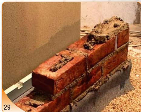
Nanesení zdicí malty na roh zdiva.
