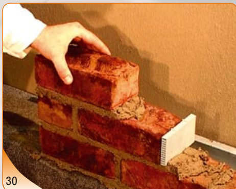
Založení rohu zdiva na celou délku zdicí cihly.
